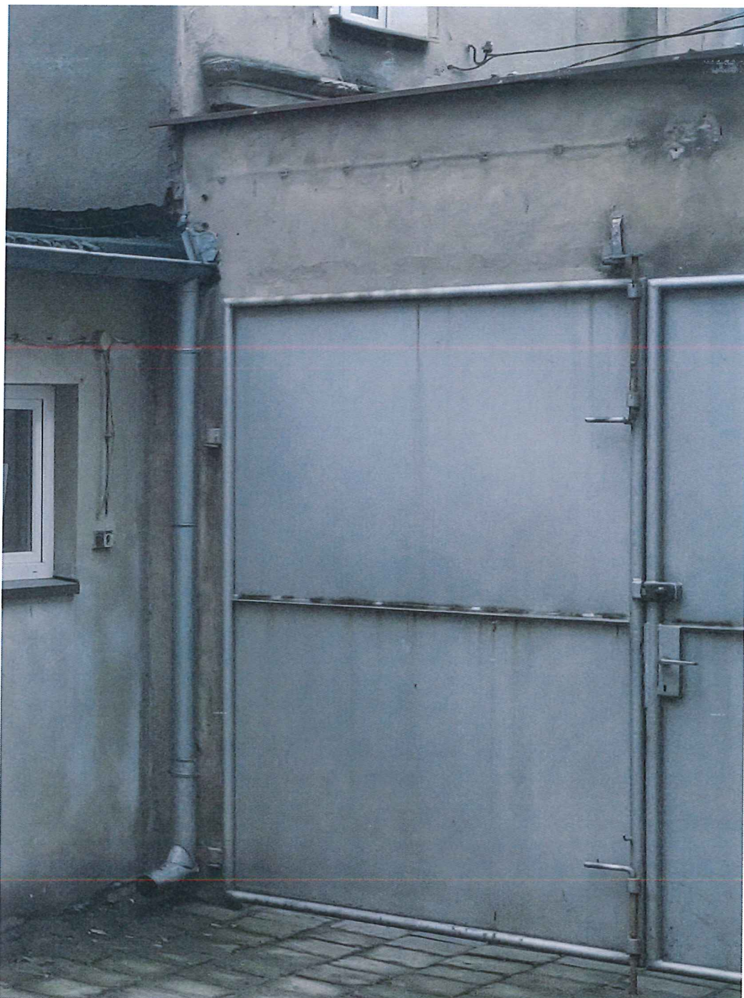
Fot. 7. Podwórze przy budynku do rozbiórki – widok fragmentu ogrodzenia z bramą od strony wschodniej; nadproże tego otworu bramowego w murze przewidziano do rozbiórki
