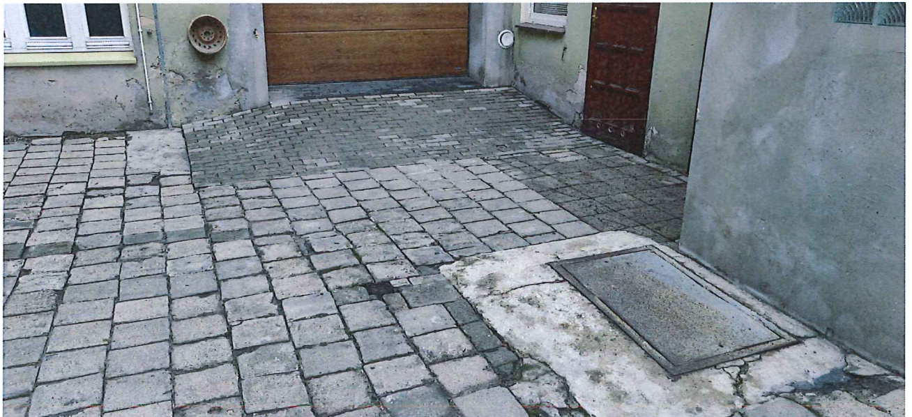
Fot. 4. Podwórze przy budynku do rozbiórki – widok pokrywy zsypu do węgla do dawnego pomieszczenia składu opału zlokalizowanego w kondygnacji podziemnej budynku Starostwa
