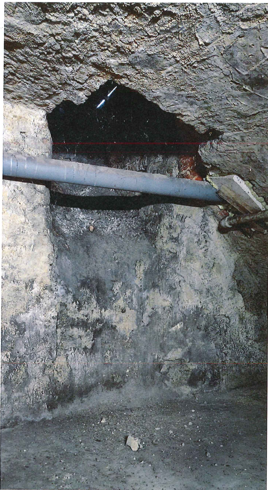
Fot. 5. Piwnica w kondygnacji podziemnej budynku Starostwa (dawny skład opatu) do likwidacji – widok zsyphu do węgla od wnętrza pomieszczenia
